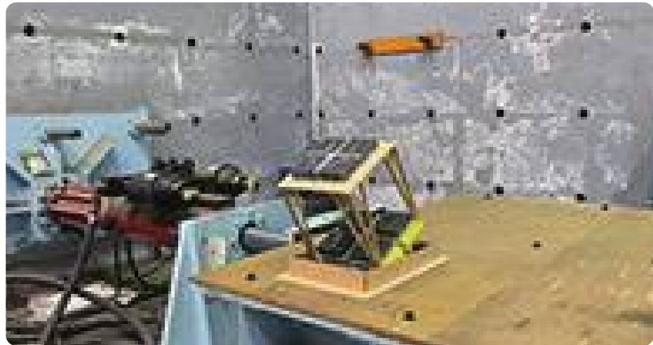
模型崩塌照片
