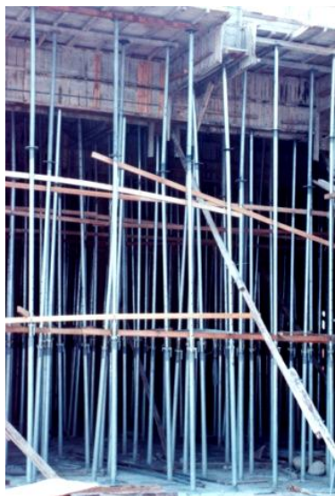
圖 3 單層組搭工地現場
