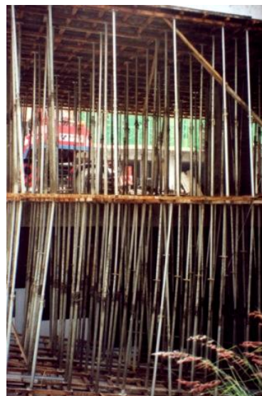
圖 4 雙層組搭工地現場
